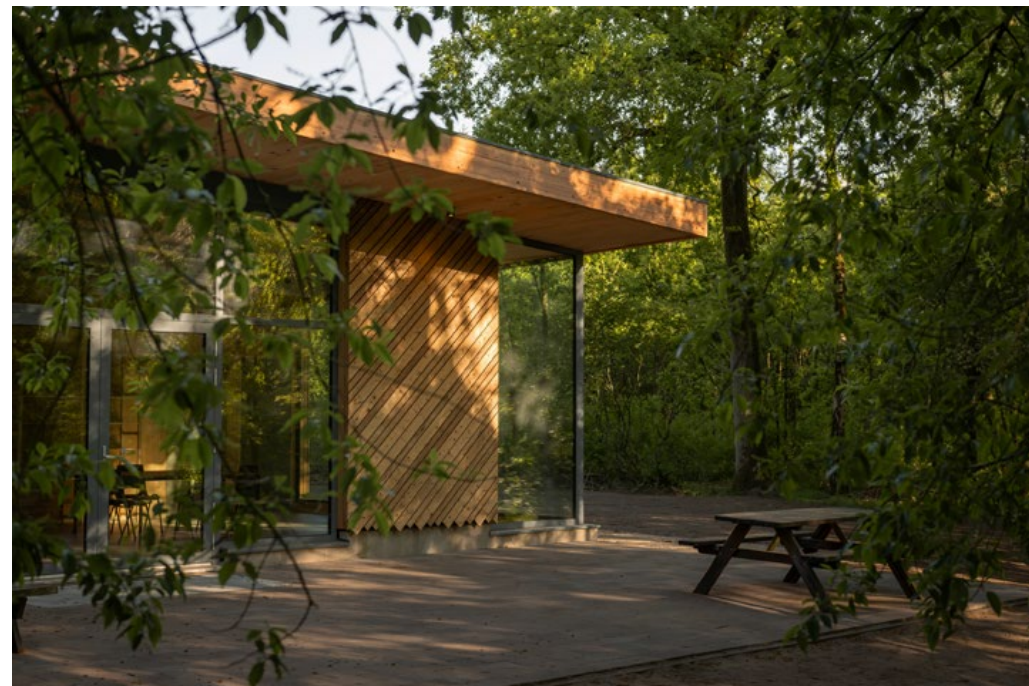
Diepe dakoverstekken en diagonale houten gevelbekleding creëren beschutte buitenruimten in het bos.
