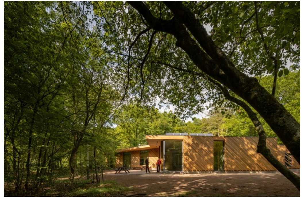
Het samenspel van gebouw en bos vormt buitenruimten — de 'boskamers' — voor spel, ontdekking en groepsactiviteiten.
