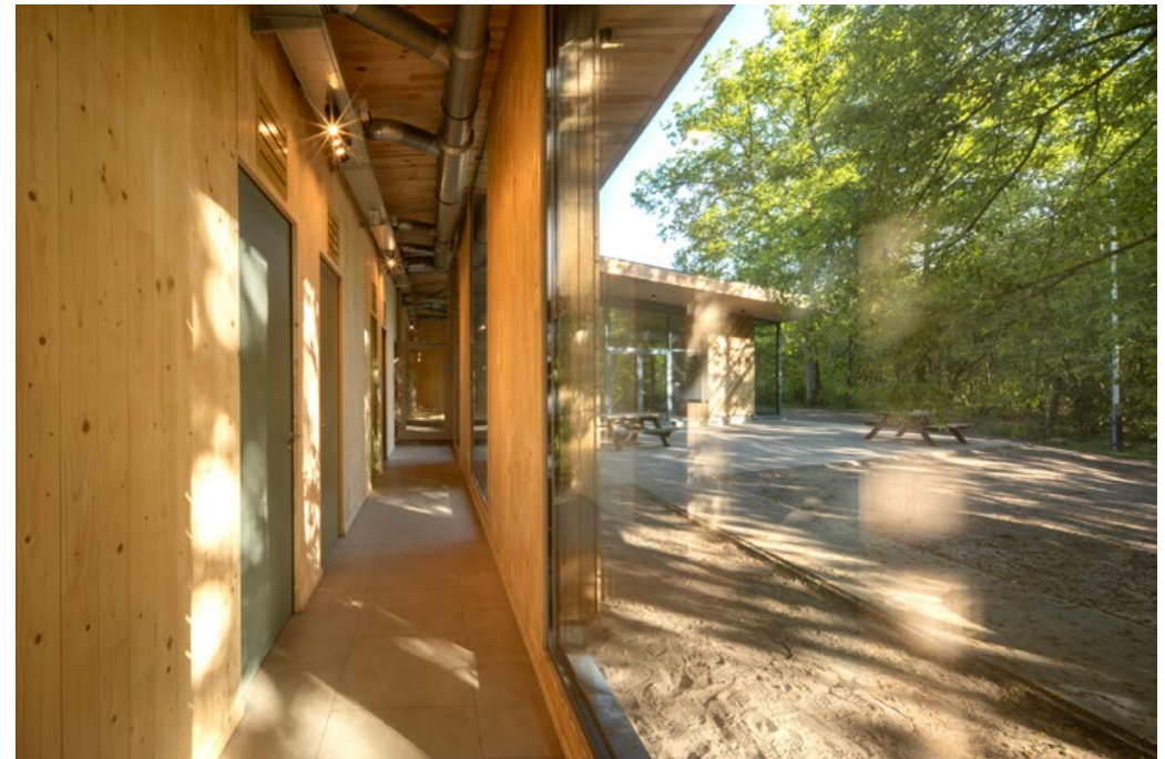
Vanaf de galerij langs de slaapvertrekken opent het zicht zich naar het omliggende boslandschap en de "boskamer".
