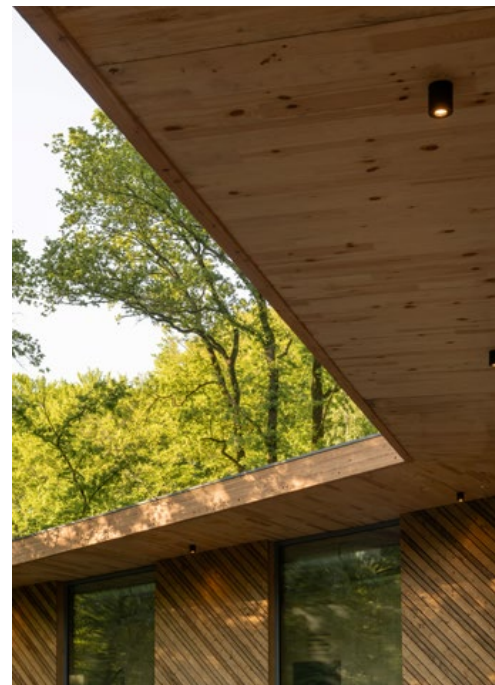
Het CLT dakoverstek biedt beschutte buitenruimte, de randbalk is uitgevoerd in larikshout en mede fungeert als waterlijst.
