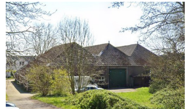
Bestaande situatie januari 2021 gezien vanaf de Zegwaartseweg
