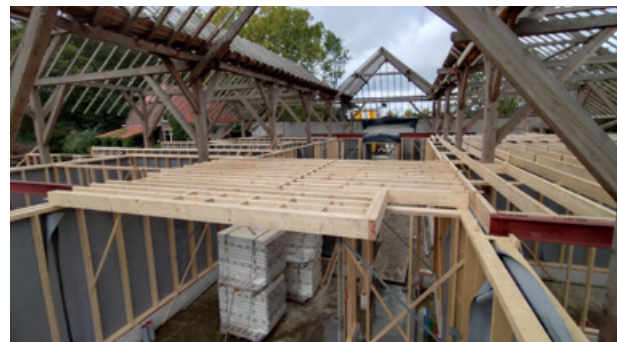
Houten verdiepingvloer en wanden worden aangebracht
