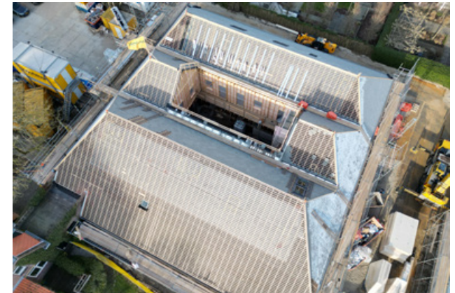
Bouw nieuwe patio in het hart van het gebouw
