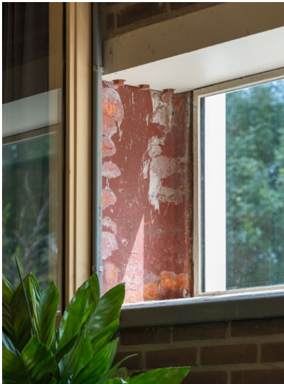
Fragment aansluiting inbouw en raam
